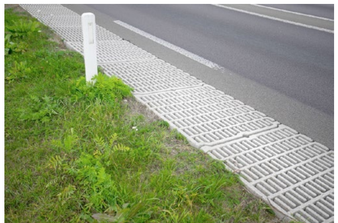
Figuur 1 Ingegraven diffractor (Whisstone, foto: 4Silence).
