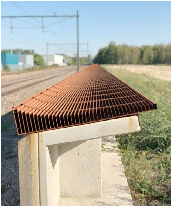
Figuur 3 Diffactor geïntegreerd op betonelement (Whiswall, foto: 4Silence).
