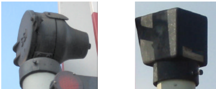
Figuur 1 De elektromechanische overwegbel (links) en de elektronische overwegbel (rechts)
